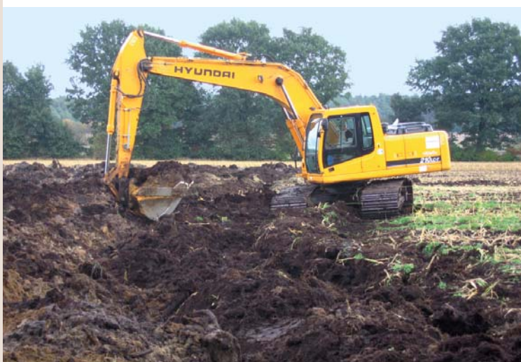
Bagger bei Kühlungsarbeiten im ›Großen Moor bei Uchte‹
